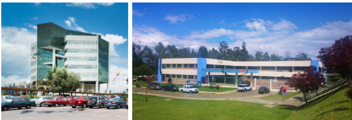
Figura 20 y 21: Edificio de oficinas del rectorado y edificio de oficinas y laboratorios de ingeniería mecánica. ESPE
