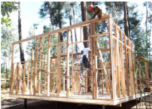
Figura 8 y 9: Estructura del edificio
